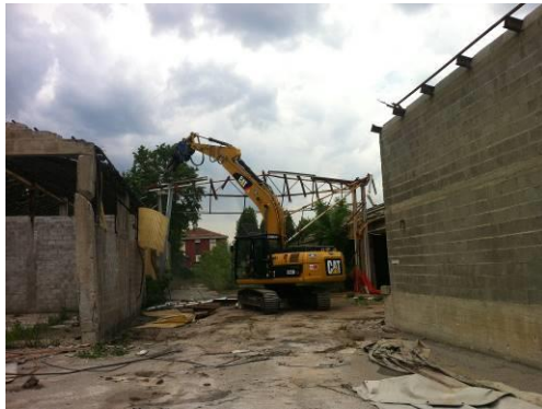
Fasi di demolizione fabbricati
