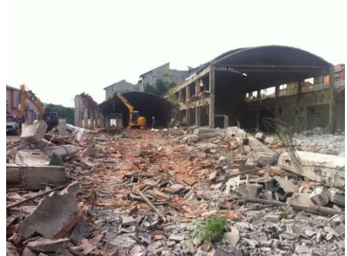
Fasi di demolizione fabbricati
