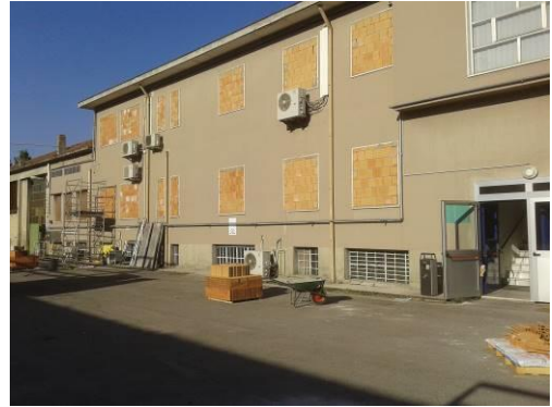
Palazzina dopo la messa in sicurezza
