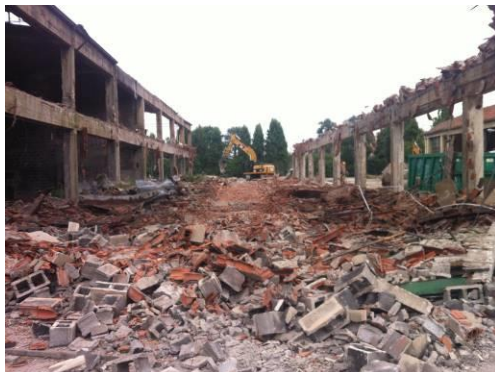
Fasi finali demolizione fabbricati
