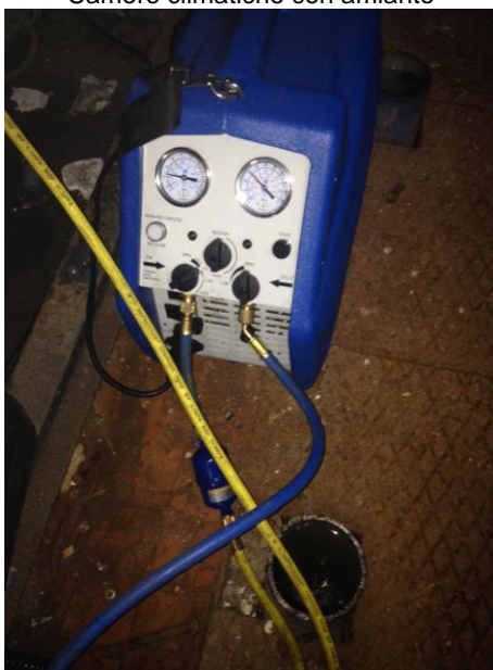
Bonifica gas refrigeranti e stoccaggio all'interno di contenitori a pressione
