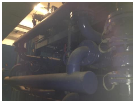
Camere climatiche con amianto
