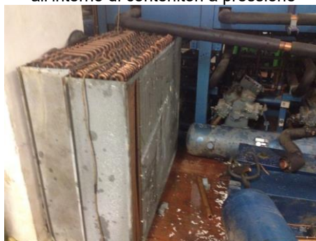
Fasi della demolizione interna
