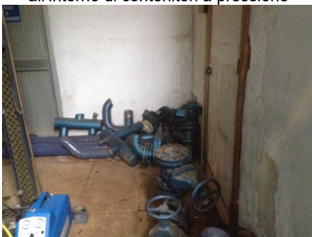
Fasi della demolizione interna
