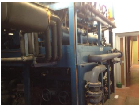
Camere climatiche con amianto
