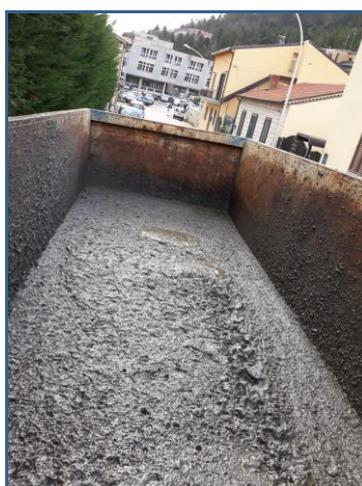
*Stoccaggio in container a tenuta stagna delle terre contaminate aspirate*
