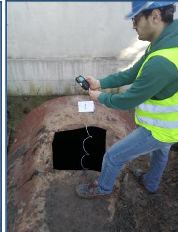
*Misurazione presenza di gas e livelli di esplosività*
