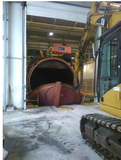
Demolizione autoclave
