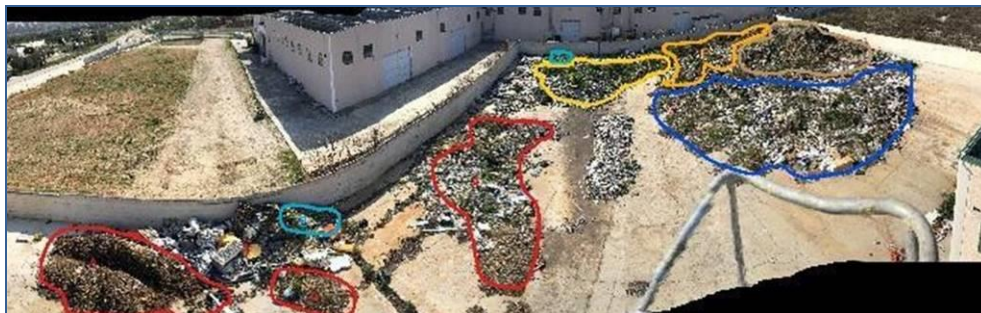
Manufatto ante operam
