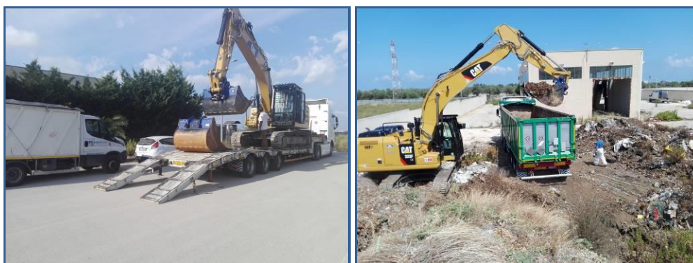
Carico rifiuti contaminati con escavatore
