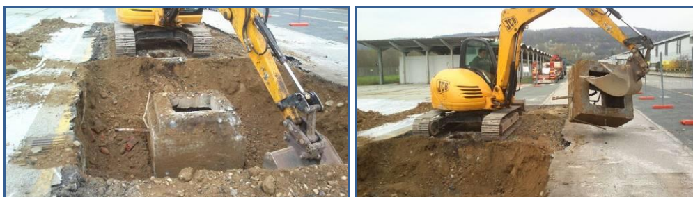
Rimozione pozzetti
