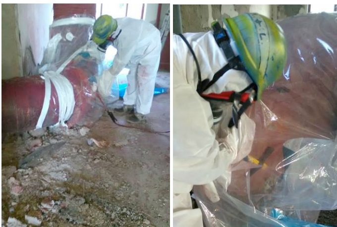
Bonifica impianti e manufatti contenenti amianto
