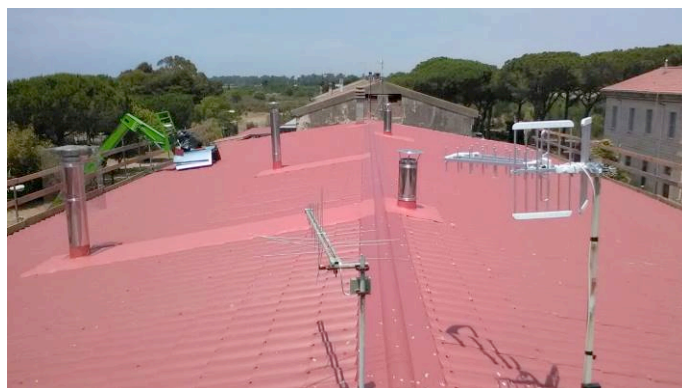
Ripristino coperture post bonifica
