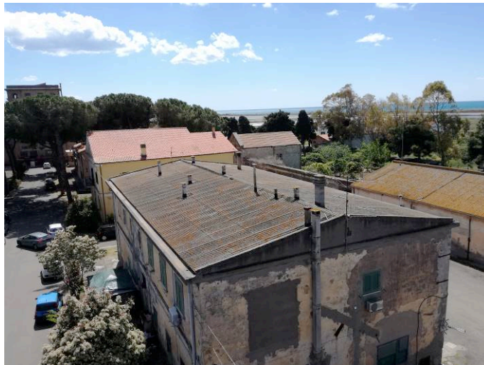
Edificio principale – coperture oggetto di bonifica
