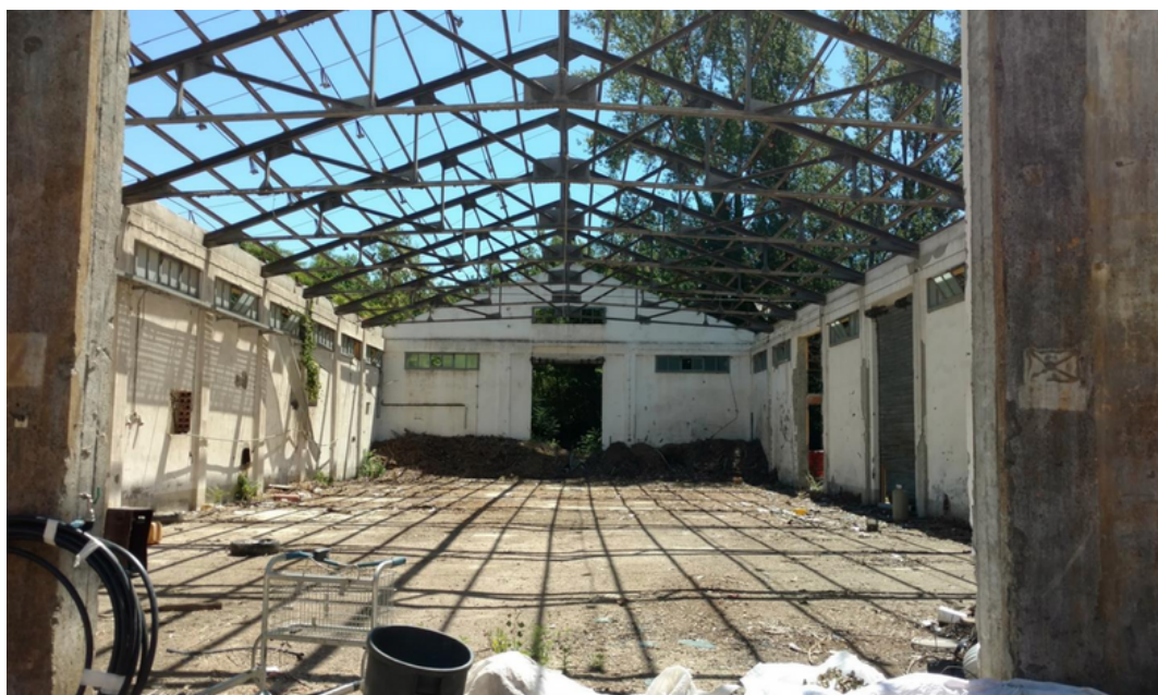
Rimozione dell'amianto in copertura - DOPO
