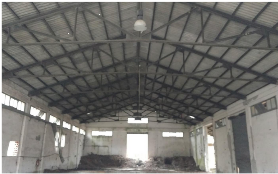
Rimozione dell'amianto in copertura - PRIMA
