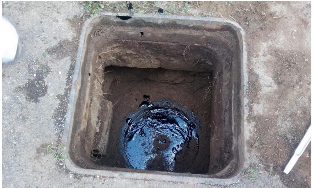
Aspirazione serbatoio e misurazione livelli di esplosività
