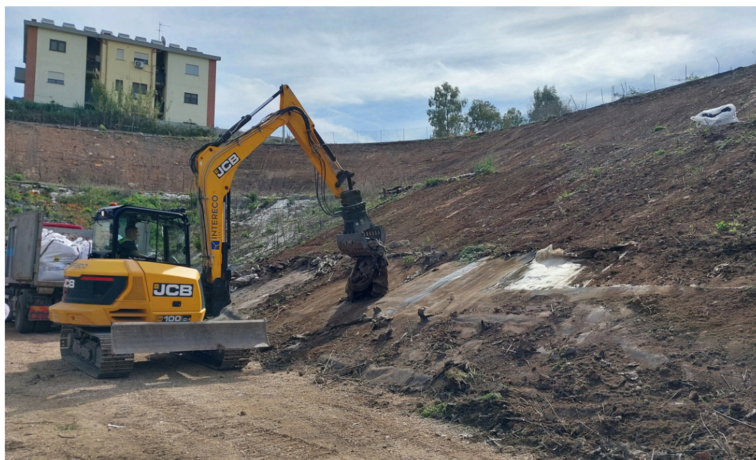
Rimozione pacchetto di sponda danneggiato
