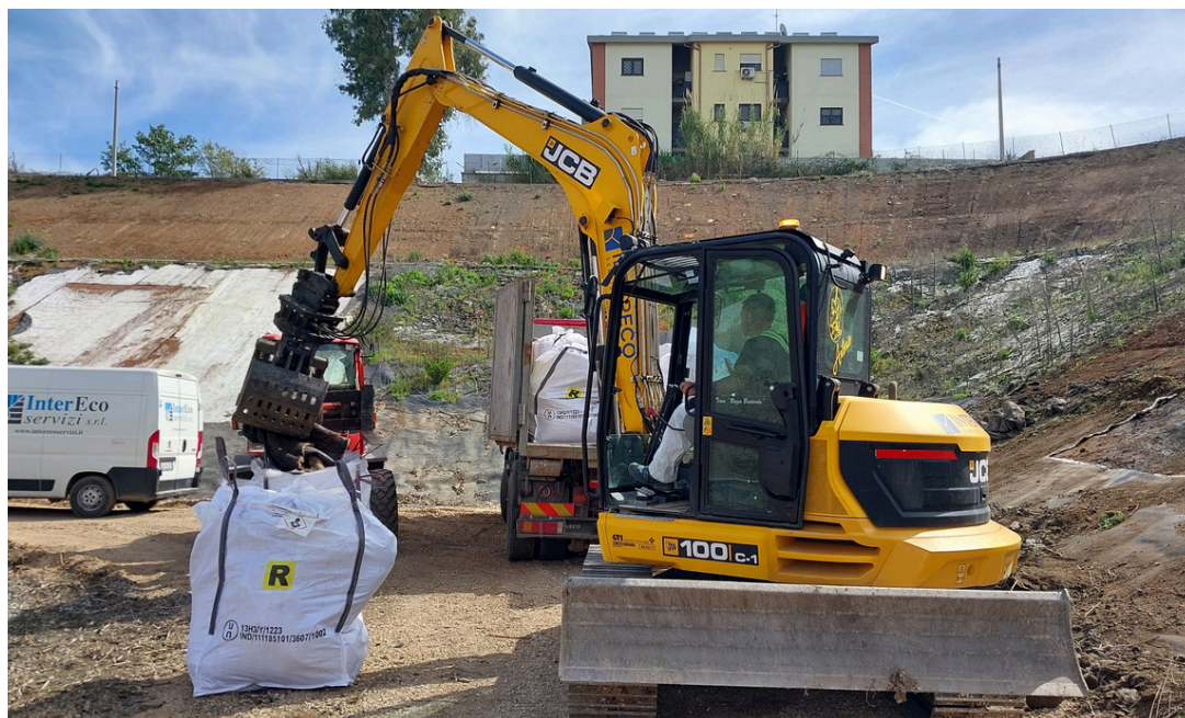
Rimozione pacchetto di sponda danneggiato
